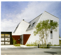
L'enduit blanc des maçonneries en briques, le bois des écrans pare-vent et les végétaux du patio d'entrée composent la façade principale marquée par un pan incliné vers le sud intégrant les capteurs solaires. (Doc. Tikhéni Architectes.)
