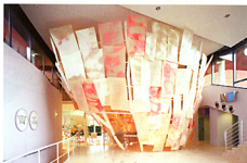
La structure métallique arborescente composée de panneaux en résine polyester coulée sous vide
